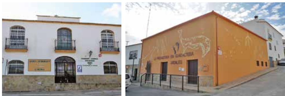
Figuras 5 y 6. El Centro antes y después de la intervención
