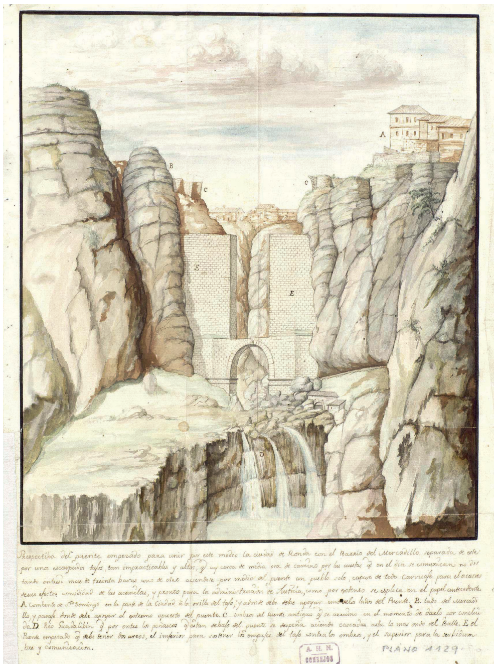
Figura 2. Estado de la construcción del Puente Nuevo en Febrero de 1785.
