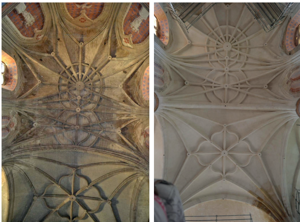
Figura 16. Las bóvedas de la Iglesia de la Encarnación antes de la rehabilitación (izquierda) y durante la misma (derecha)
