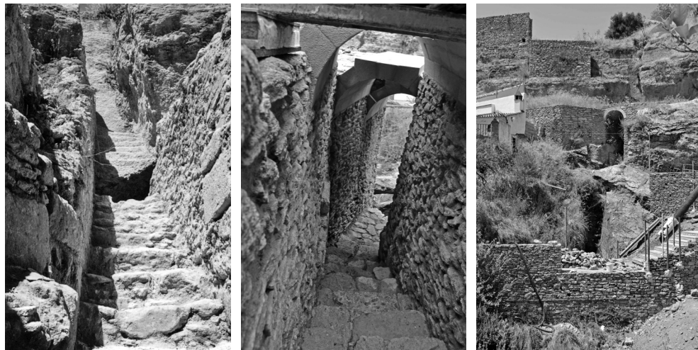
Figura 10. Imagen de la derecha: visualización de las escaleras del cuerpo uno y dos. Imagen central: escalera del cuerpo dos, dando acceso al pozo. Imagen izquierda: Obra ilegal realizada sobre la Coracha de Setenil seccionándola y ejecutada por el Ayuntamiento de Setenil en el año 2017, paralizada por la Delegación de Cultura de Cádiz e intervenida por el SEPRONA, pero que de forma definitiva ha destruido más de seis metros del BIC de la Coracha de Setenil)
