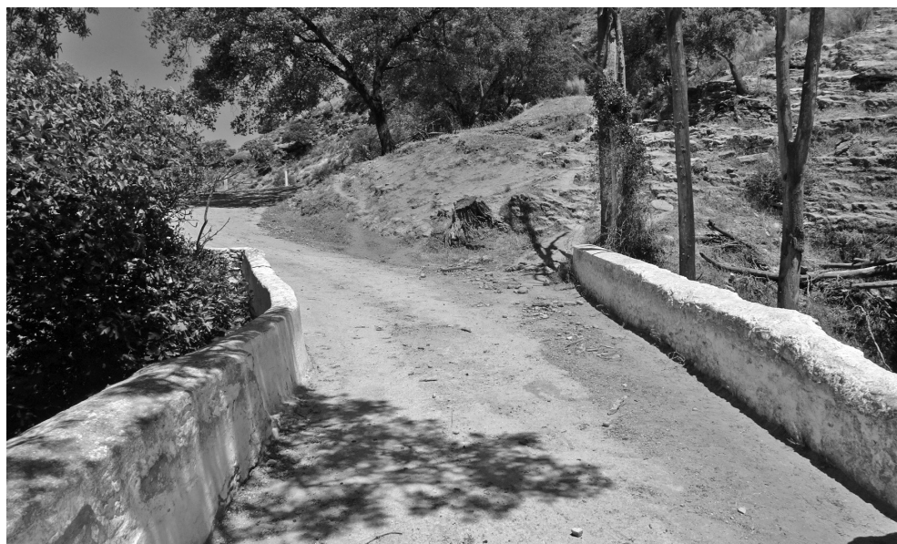
Figura 12. La calzada del puente
