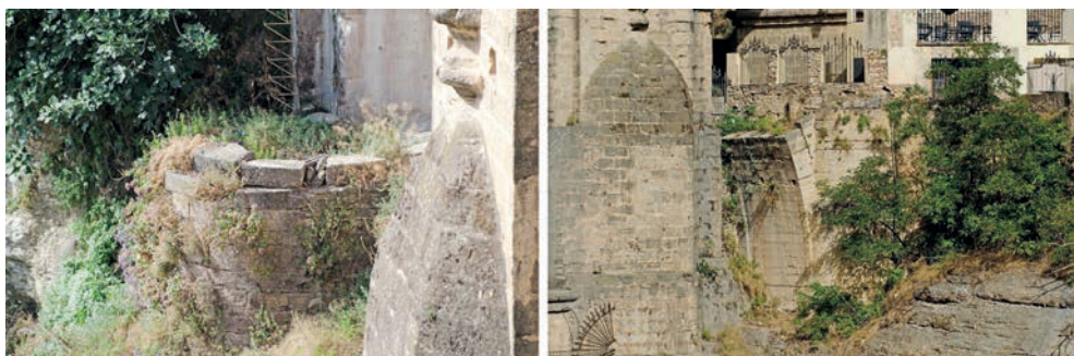
Figura 5. Arranques del precedente del Puente Nuevo. Fotografías del autor
