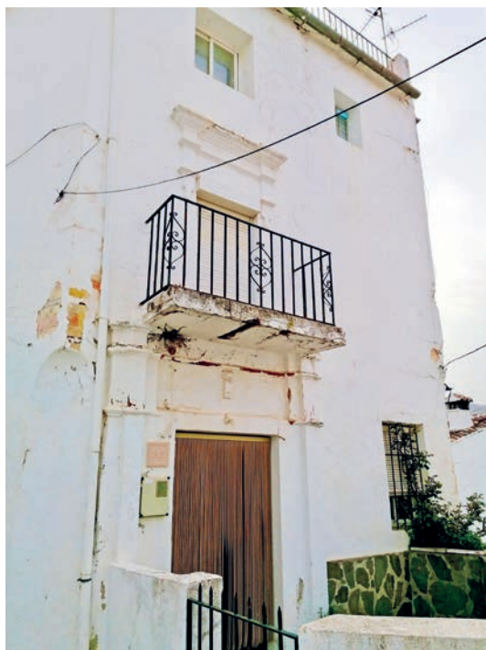
Figura 8. Parauta. Calle Larga n.º 30. Este edificio muestra, además de su portada dieciochesca, unas pinturas murales muy fieles a los ejemplos de la ciudad de Málaga. Técnica frecuente en el siglo XVIII. Fotografía del autor
