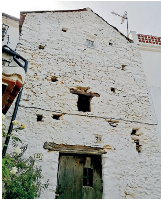
Figura 4. Benalauría. Casa con técnicas de construcción moriscas y piedra prácticamente desnuda. Fotografía del autor
