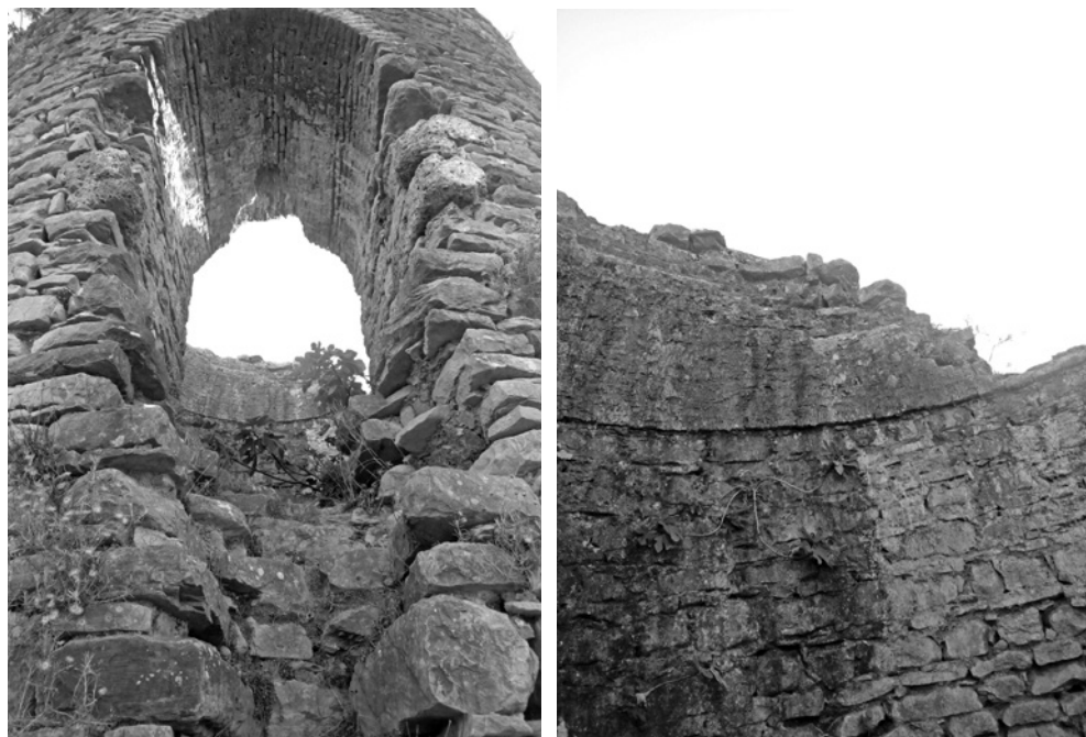
Figura 8. Puerta de entrada (izquierda) y bóveda (derecha)
