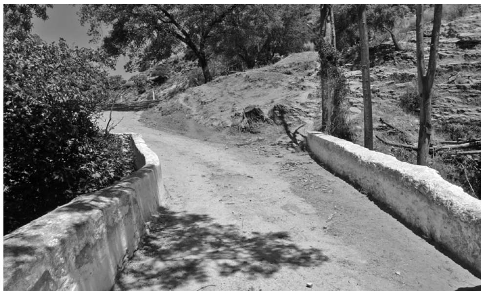
Figura 12. La calzada del puente
