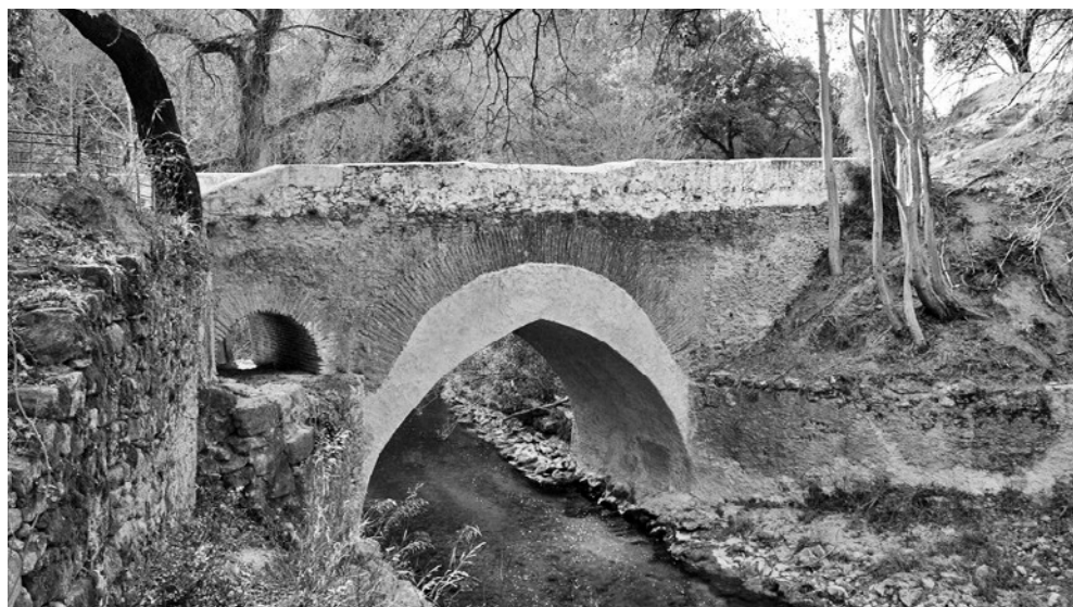
Figura 11. El Puente de El Duende
