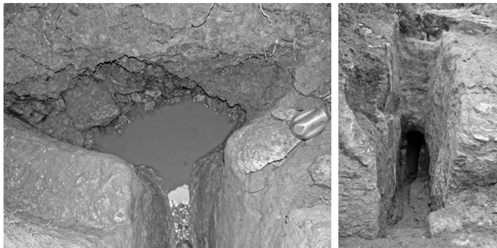
Figura 9. Imagen de la izquierda: pozo de la coracha. Imagen de la derecha: entrada a la mina y acceso al pozo principal, se puede observar el sistema de desagüe, el arranque de los arcos y el sistema de cierre de la mina.
