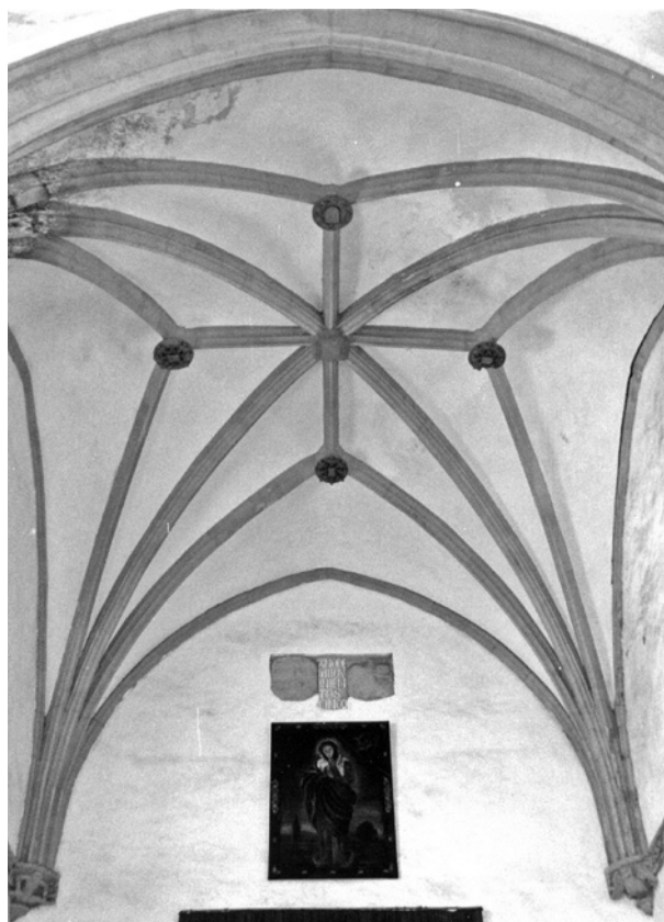
Figura 2. Bóveda estrellada gótica en la capilla mayor de la antigua iglesia del monasterio de San Francisco, h. 1505
