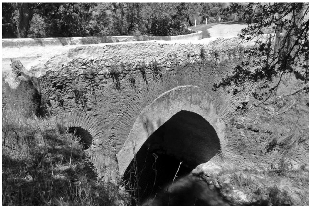
Figura 9. El puente de El Duende
