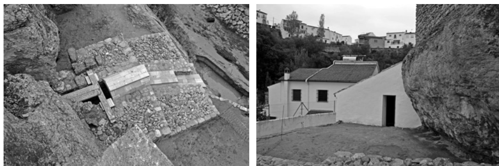
Figura 11. Imagen de la izquierda: Rehabilitación de la coracha de Setenil en sus torres dos y tres. Imagen de la derecha: Creación del Centro de Interpretación de la Coracha, actualmente completamente abandonado y en desuso, de igual forma se encuentra a día de hoy la propia Coracha de Setenil.
