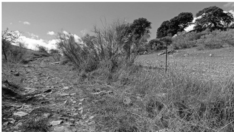
Figura 1. El empedrado (seguramente romano) del antiguo camino a Benaoján, antes de su destrucción en 2015
